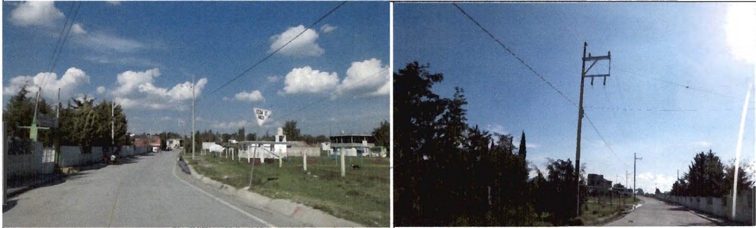
Fotografías de la Obra
