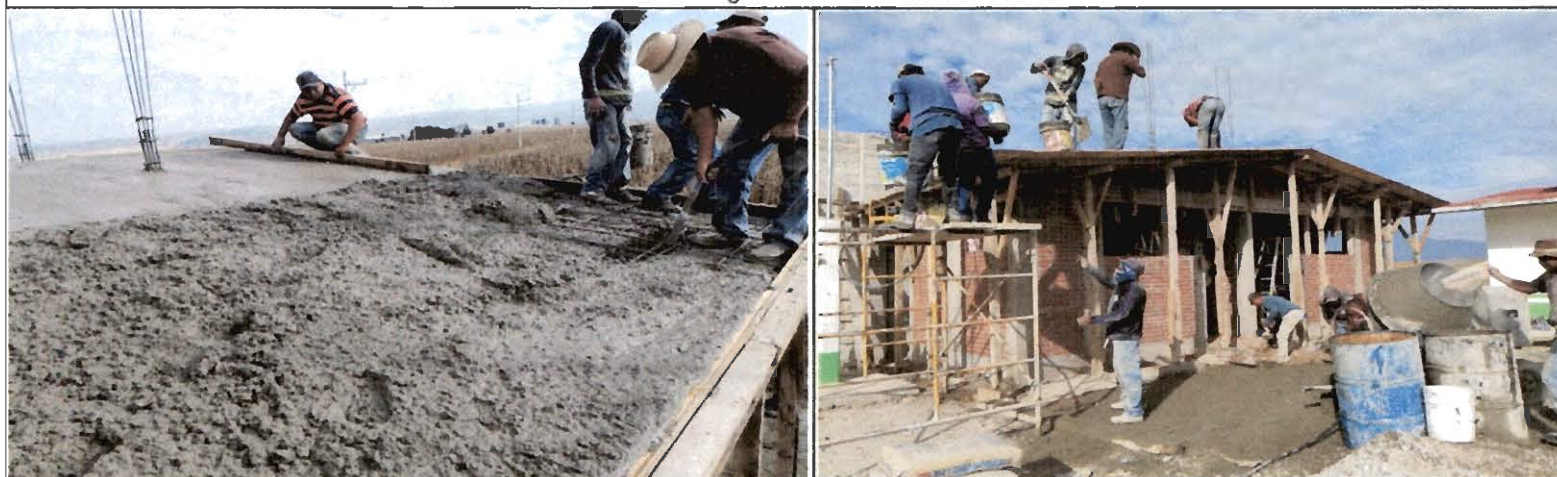
Fotografías de la Obra
