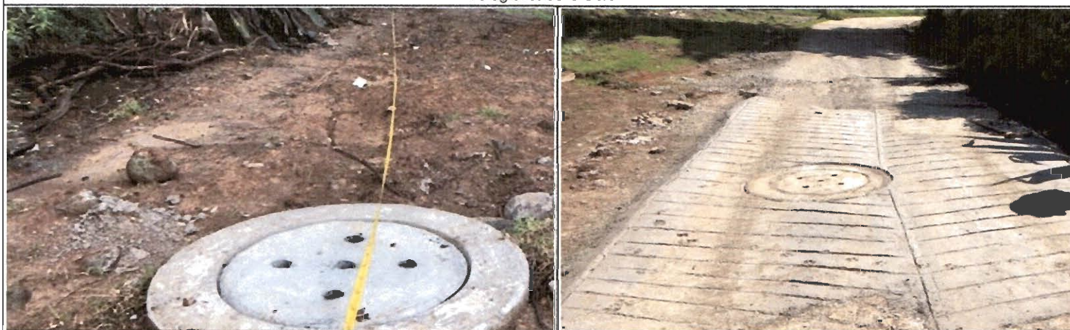
Fotografías de la Obra
