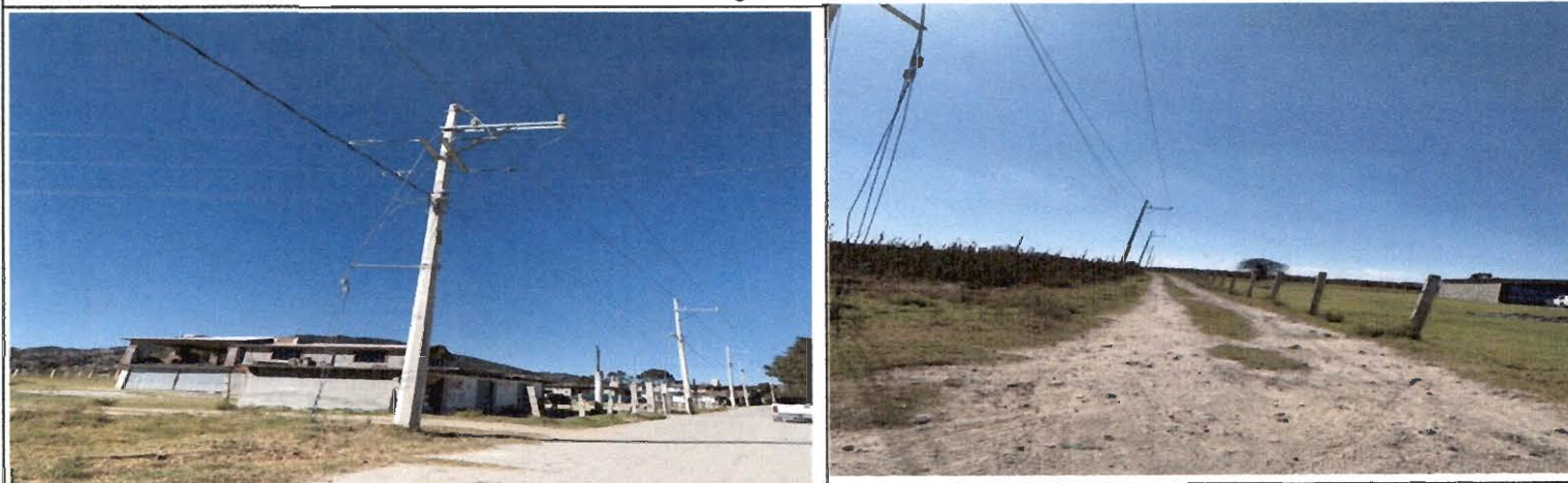
Fotografías de la Obra
