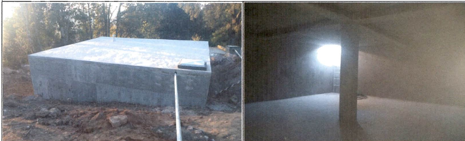
Fotografías de la Obra
