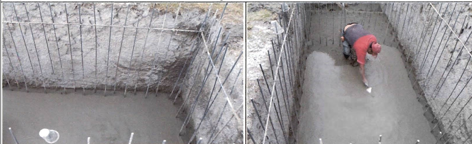
Fotografías de la Obra
