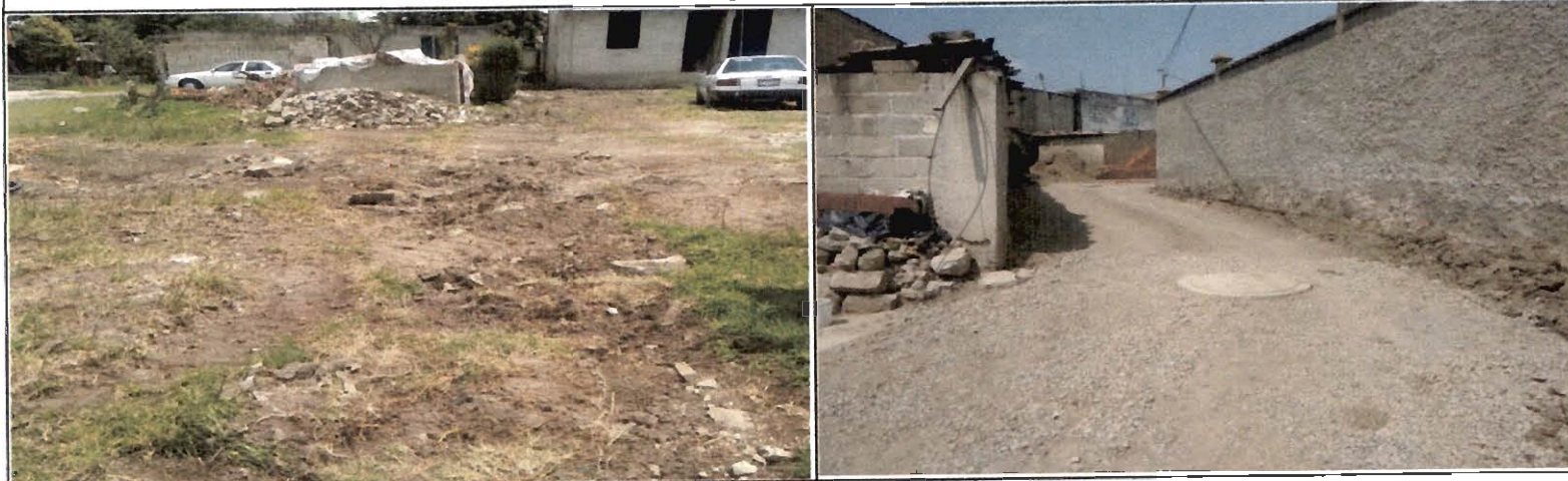
Fotografías de la Obra
