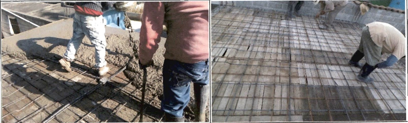
Fotografías de la Obra
